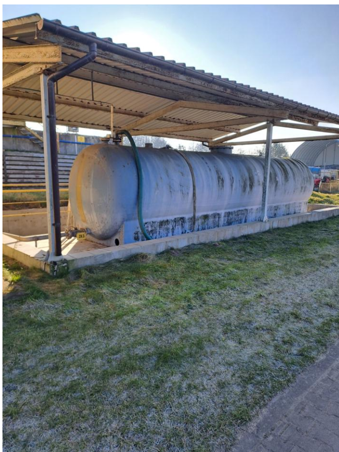
Rys. 6 Stanowisko koagulantu PIX
